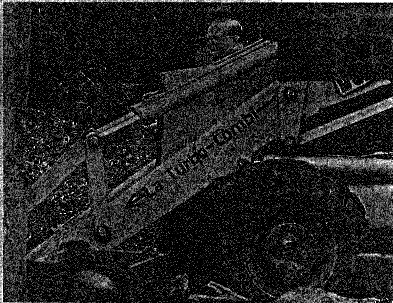
Luis Falcón, tras una excavadora en las obras de un edificio en un solar de Vilagarcía. VÍCTOR MEJUTO
